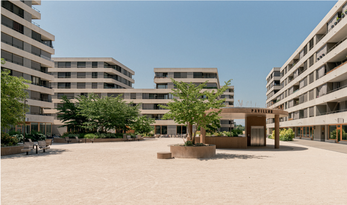
Belle-Terre, bâtiment Jura Lin Robbe Seiler avec BLSA
