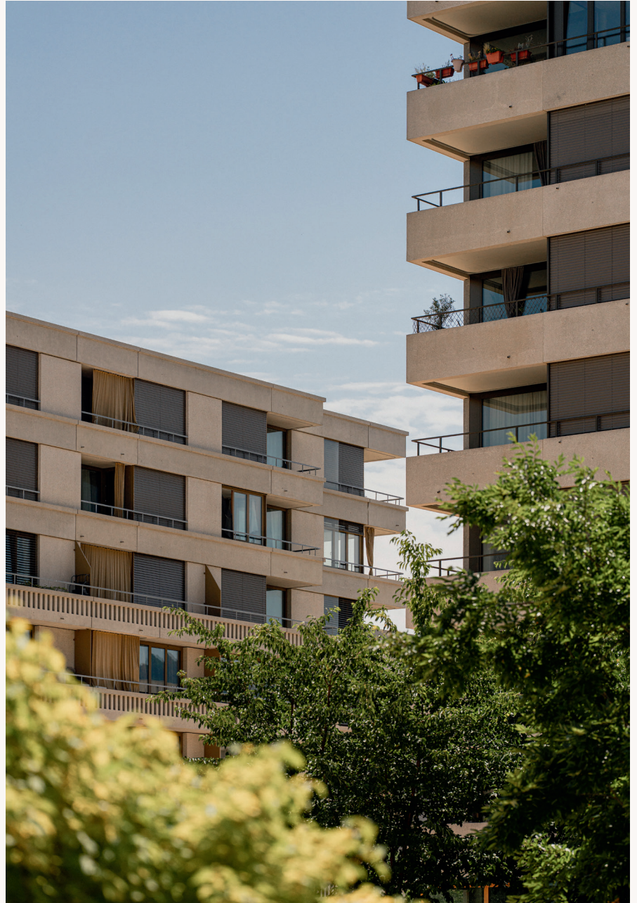
Belle-Terre, bâtiment Voirons, Jaccaud+Associés
